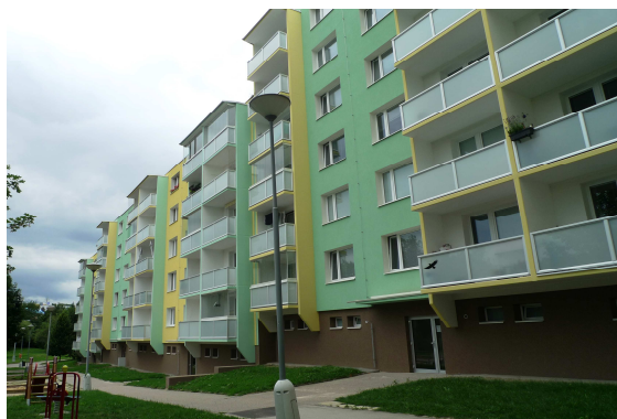
Foto č. 1 – pohled jihovýchodní
